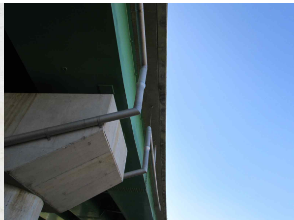
&lt; 배수관 시공 상태 &gt;
