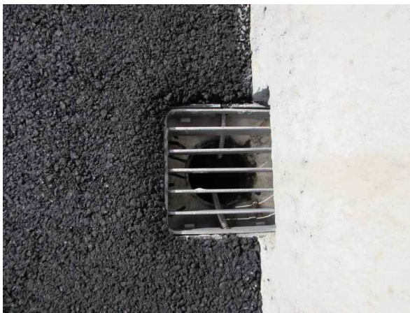
&lt; 배수구 시공 상태 &gt;
