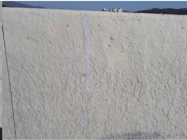
< 중앙분리대 보수 완료 >
