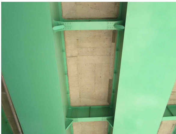
&lt; S1 바닥판하면 상태 양호 &gt;
