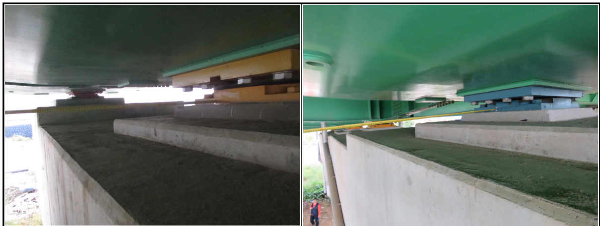
<그림 2.3.1> 연단거리 측정 (장호원방향)
