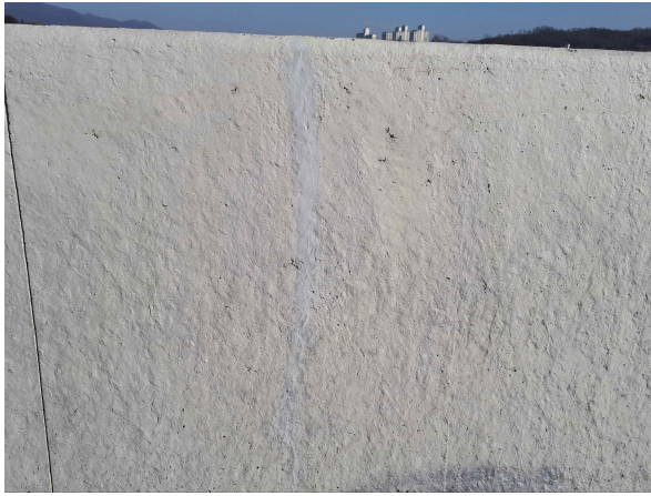
< S1 방호벽 균열 보수 >
