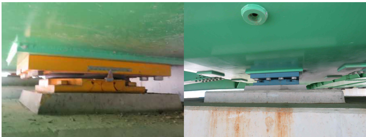
< A1 교량받침 상태 >
