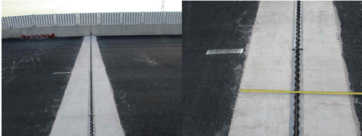
< A2 신축이음장치 상태 양호 >
