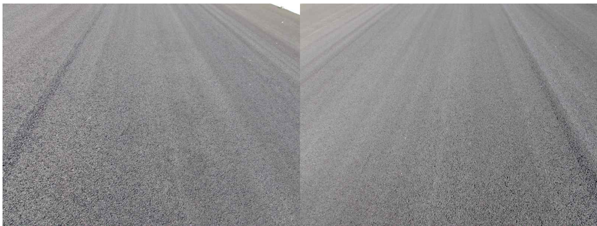
< 교면포장 상태 양호 >
