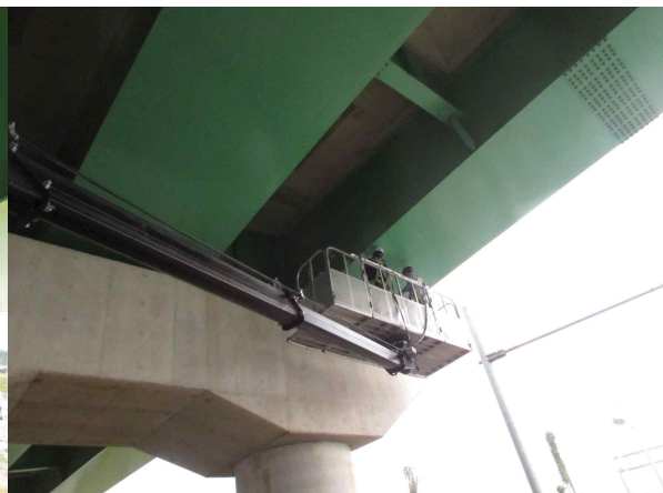
<점검차를 이용한 외관조사 현황>
