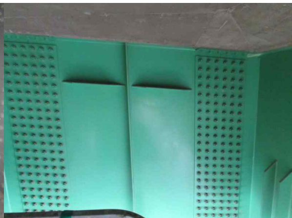
< 가로보 상태 양호 >
