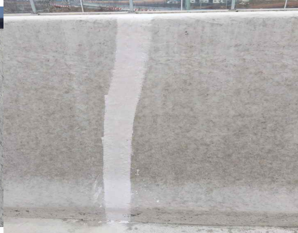
< S3 방호벽 균열 보수 >
