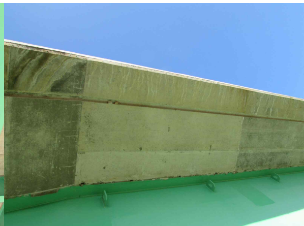
&lt; S2 바닥판하면 캔틸레버부 상태 양호 &gt;
